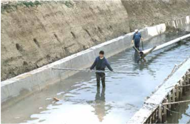
Merancho de los Giles - Con encofrado y anchura superior a 4 metros
