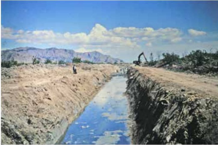
Merancho de los Giles-Inicio de la excavación 1974
