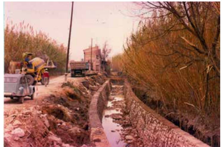
Azarbe Mayor en construcción 1976
