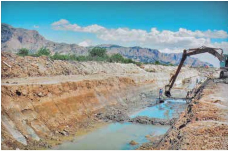
Merancho de los Giles-Final excavación
